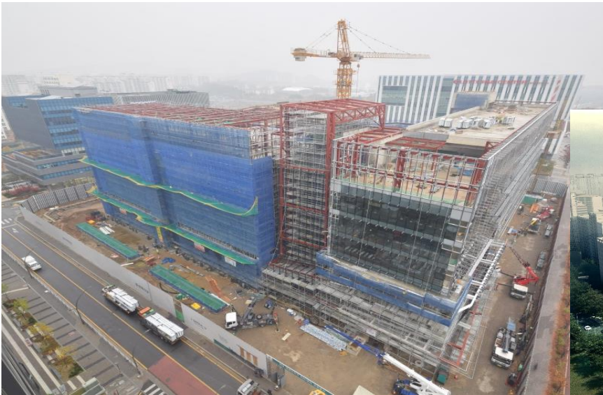
R&D센터 건설 현장
